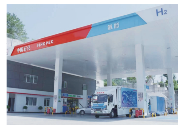
中国石化重庆石油已在重庆市率先投营了4座加氢站(重庆石油供图)
