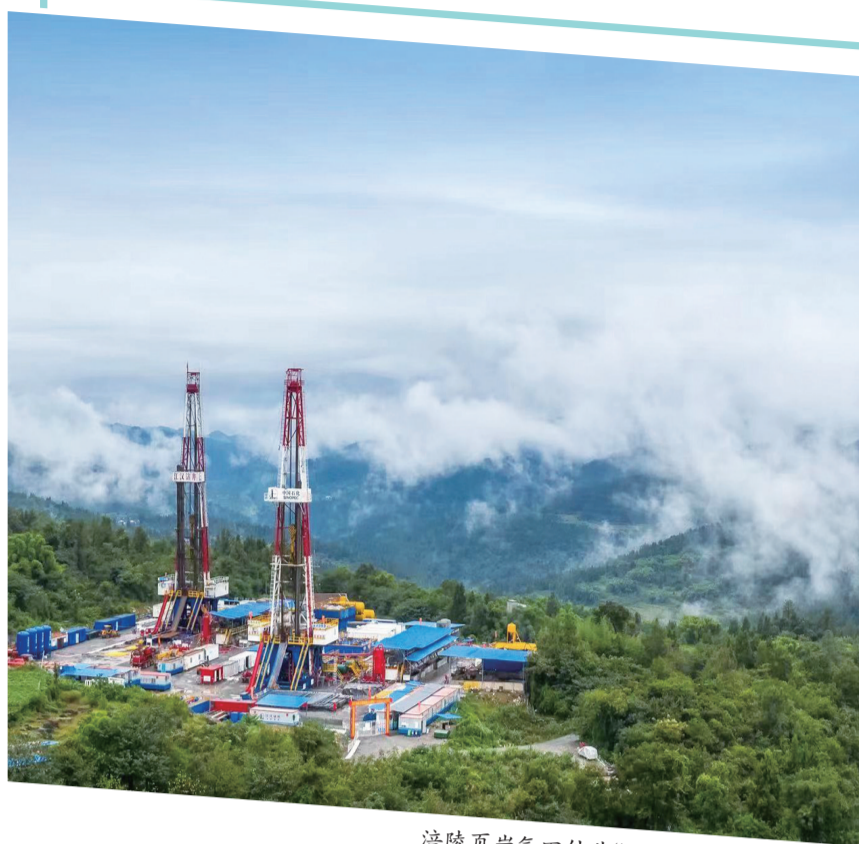
涪陵页岩气田钻井“井工厂”航拍 摄/向阳
