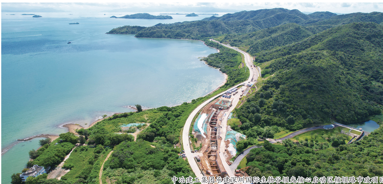
中冶建工集团承建深圳国际生物谷坝地核心区启动区核网路市政项目
