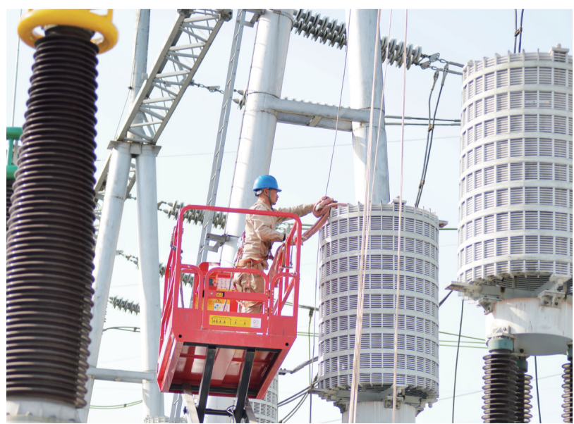
11月21日,国网重庆市区供电公司员工在220千伏黄荆堡变电站拆除阻波器 and 耦合电容器。
