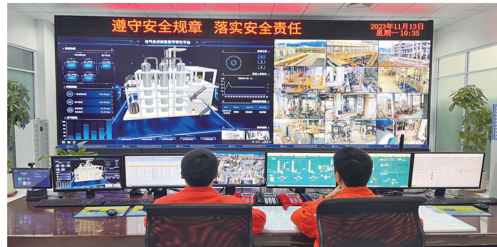
指挥中心调度员通过数字孪生平台巡查光气合成装置
