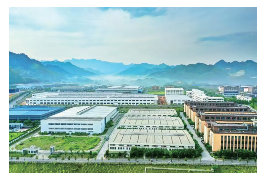
产业园区承载力日益提升 摄/尹南源
