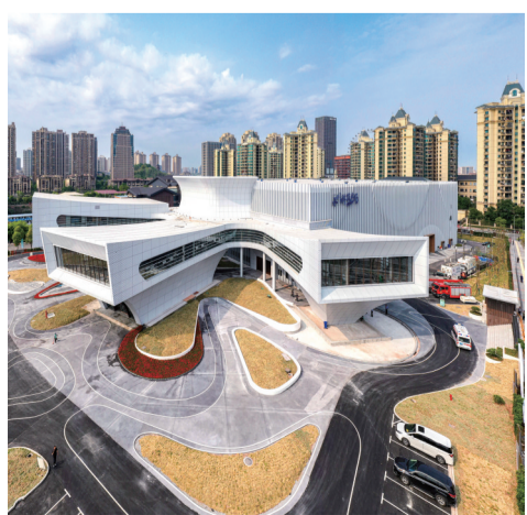
永川科技片场
