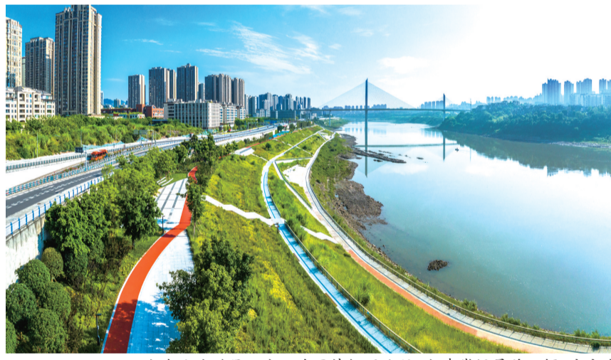
改造后的磁器口滨江片区特钢码头段,水清岸绿景美 摄/唐安冰
