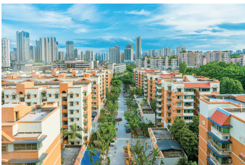
月光小区老旧小区改造
