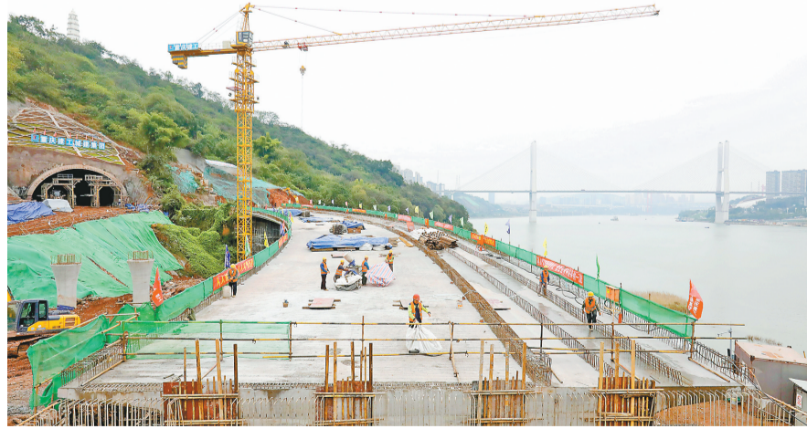
11月15日,北滨路东延伸段一期,工人们正在抓紧施工。
