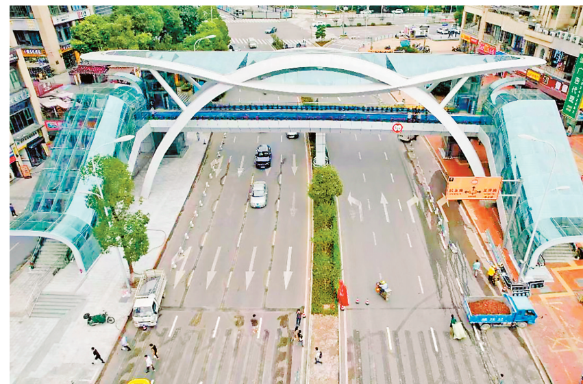
近日，在轨道3号线学堂湾站，新建成的万达旭辉人行天桥投用，方便市民出行。（市住房城乡建委供图）
