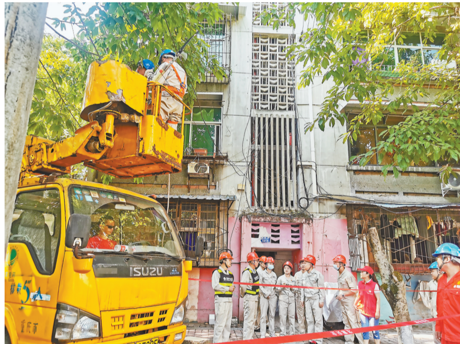
沙坪坝区石井坡街道中心湾社区供电网格员组织力量对居民院坝内遮挡高压电路的树枝进行修枝。（沙坪坝区委组织部供图）
