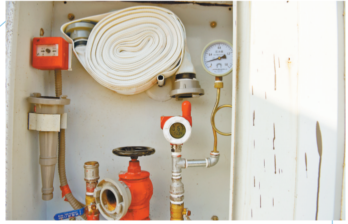
检测消防栓水压的无线数字压力表。（市消防救援总队供图）
