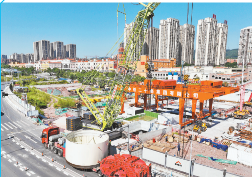
轨道交通24号线鹿角北站,第二台盾构机正在进行吊装作业。(本报资料图片)
