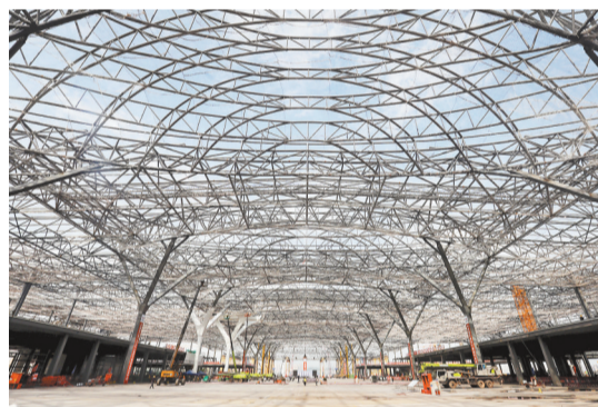
10月16日,建设中的重庆东站。
