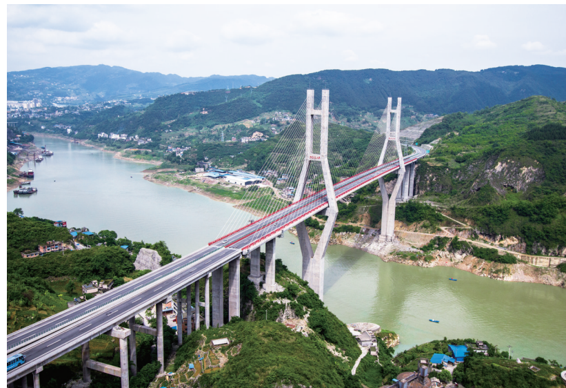
涪丰石高速荔枝乌江大桥
