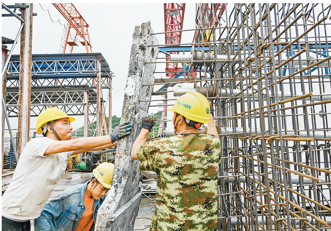
▲10月7日,北碚区渝武高速复线T梁预制场,中交一公局的工人正在制作T梁龙骨。渝武高速复线是重庆市规划“三环十二射七联线”骨架高速公路网中重要的射线之一,路线全长35.53公里,采用双向六车道设计,设计时速100公里,计划在2024年建成通车。记者 万难 摄/视觉重庆
