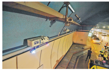
9月21日，九龙坡区华岩隧道，智能巡检机器人正在作业。 记者 郑宇 摄/视觉重庆
