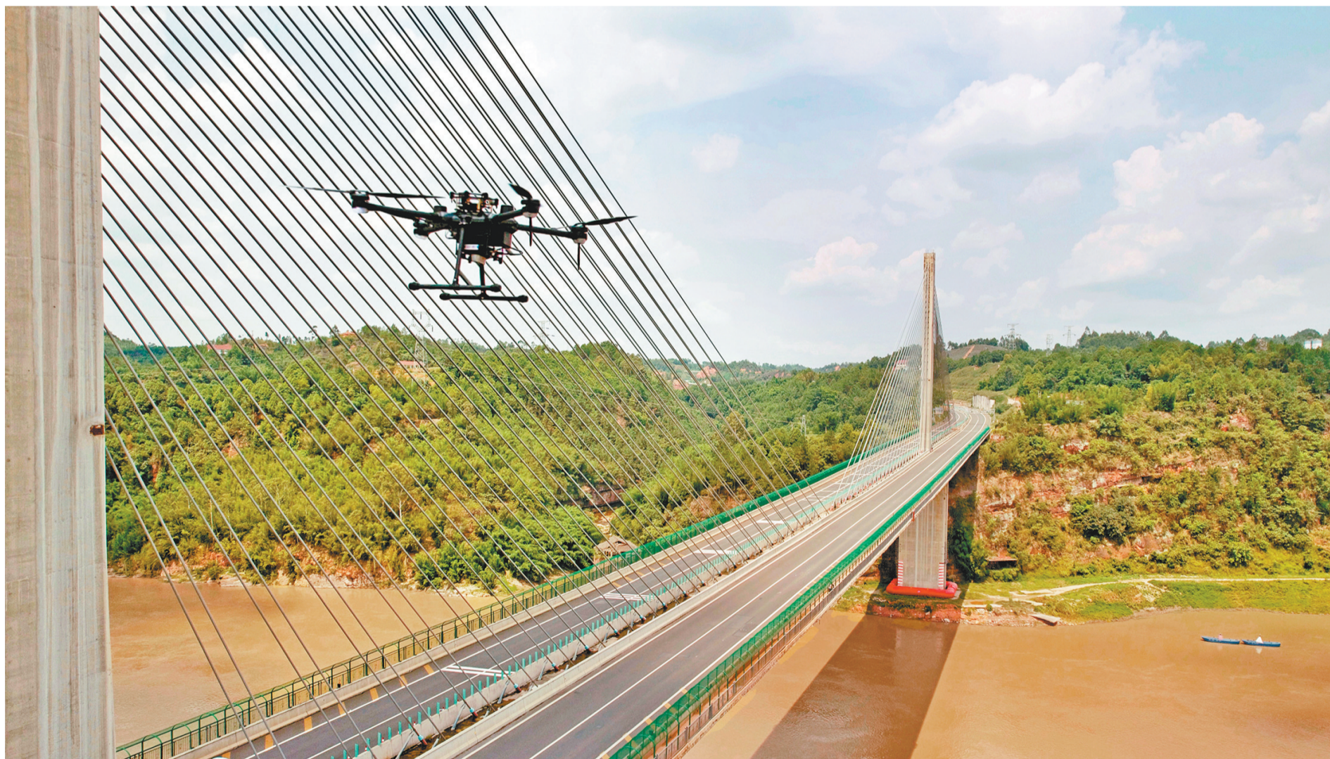
八月二十八日,四川省宜宾市岷江特大桥,重庆市交通工程质量检测有限公司自主研发的“凌志2”无人机正在检测桥梁南塔塔柱。
