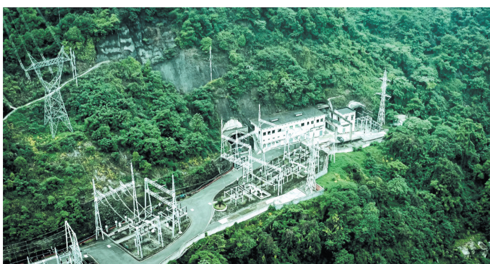
坐落在歌乐山半山腰的220千伏凉亭变电站
