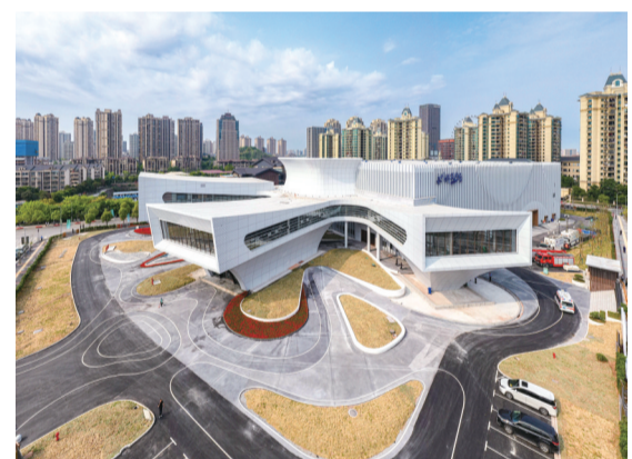
永川科技片场
