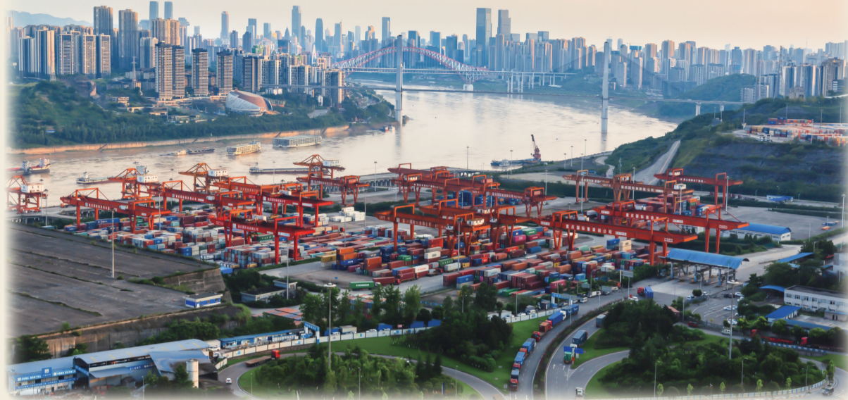
“浦发力量”为寸滩国际邮轮母港港口工程顺利实施提供金融保障 何浩芳/摄
