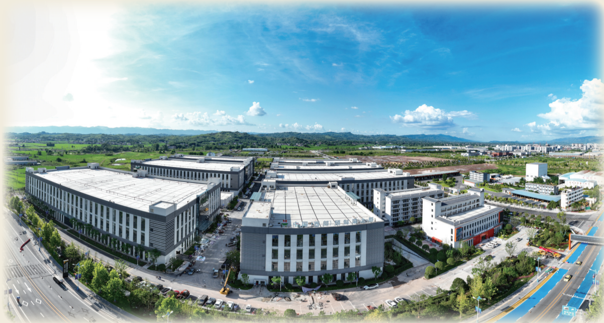
农发行重庆市分行支持的梁平高新区绿色食品孵化园标准厂房及配套设施建设项目
