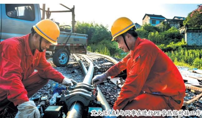
艾大迁(左)与同事在进行PE管热熔对接工作
