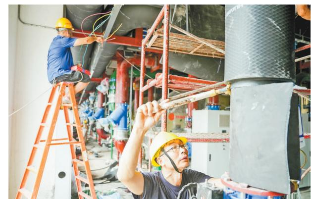
八月十七日,博世氢材料发动机项目施工现场,工人正在安装设备隔热层。记者 谢智强 摄(视觉重庆)
