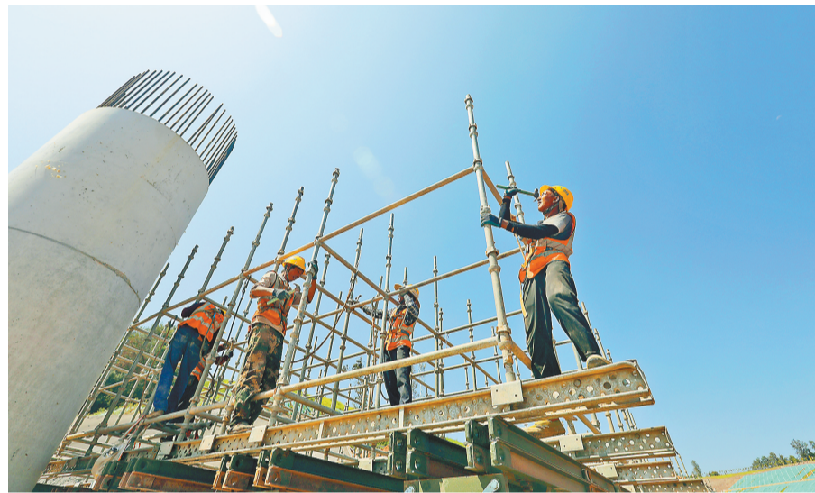
8月14日上午10点，茶惠大道东立交施工现场，技术人员正在烈日下加紧施工。 记者 罗斌 摄/视觉重庆
