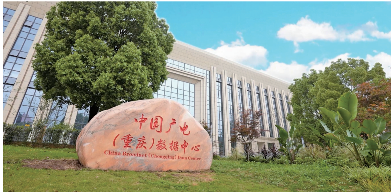
中国广电(重庆)数据中心建成投用
