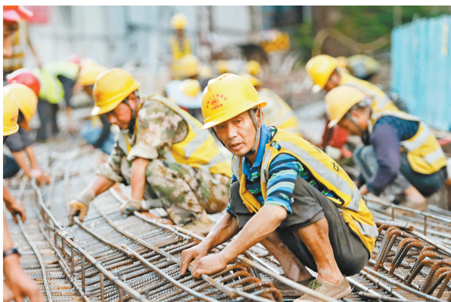
8月3日,蚂蟥立交改造C匝道拼宽桥,上百工人正抓紧时间铺钢筋,为月底浇筑做准备。 记者 罗斌 摄/视觉重庆
