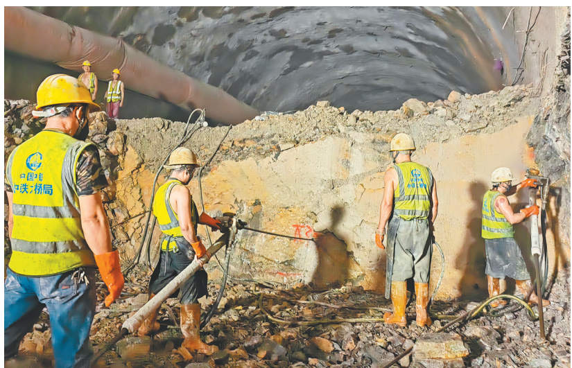
近日,陶家隧道工程一标段左洞,工人们正在进行钻孔作业。(城投建设公司供图)
