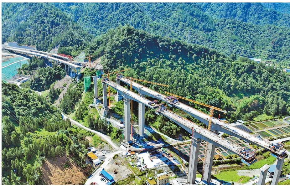
七月十七日，施工中的渝湘复线高速替溪沟大桥。特约摄影 赵勇 摄/视觉重庆
