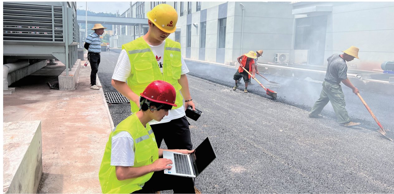
项目团队成员在施工现场调试产品
