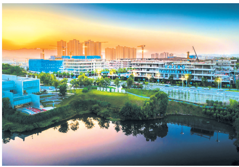
建设中的金凤城市中心 摄/曾诚
