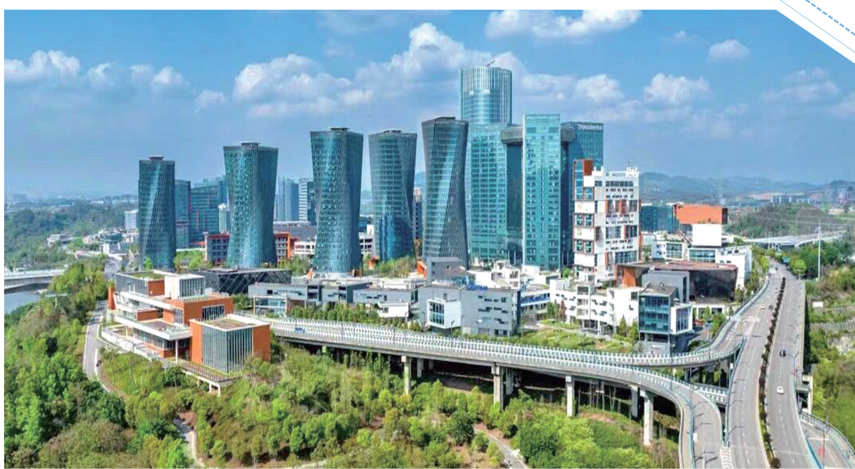
渝北区按照专业园区、存量楼宇两手抓的思路,进行“一核两区”的产业空间发展布局,倾力打造千亿级软件产业集群,软件产业加快发展。摄/尹宏伟
