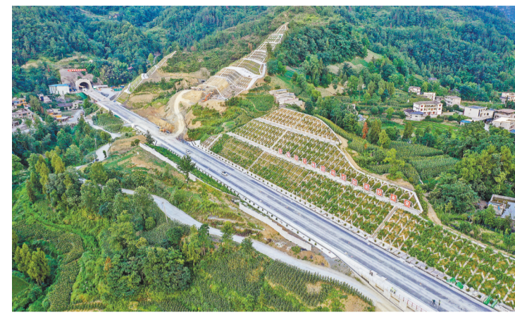
刘家山隧道外航拍。(中铁十七局供图)
