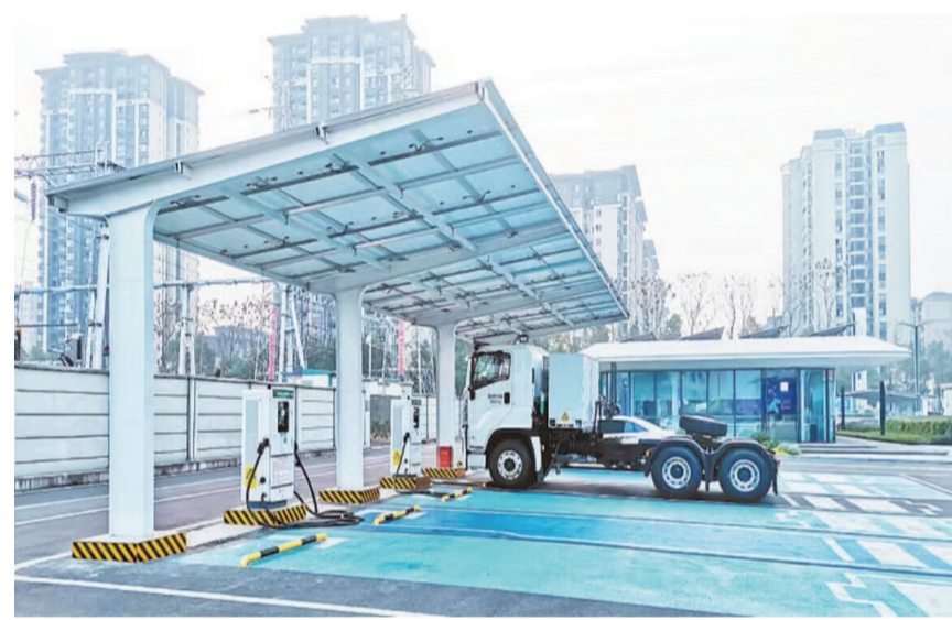
新能源车在“光储充检换”一体化综合站充电
