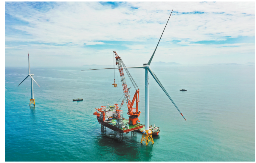
6月28日拍摄的全球首台16兆瓦海上风电机组吊装现场(无人机照片)。 记者从中国三峡集团获悉,全球首台16兆瓦海上风电机组6月28日在福建北部海域顺利完成吊装。这标志着我国海上风电高端装备制造能力、深远海海上风电施工等全产业链实现整体提升,达到国际领先水平。
