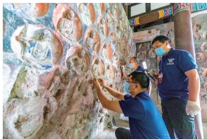
大足石刻宝顶山小佛湾造像修缮工程进入本体修复阶段
