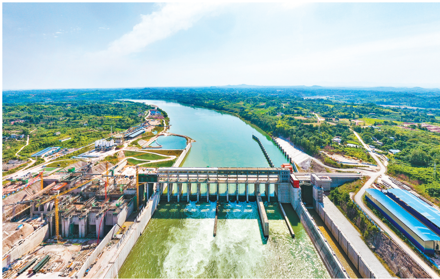
6月27日，合川区金钟村，嘉陵江利泽航运枢纽工程二期施工现场。
