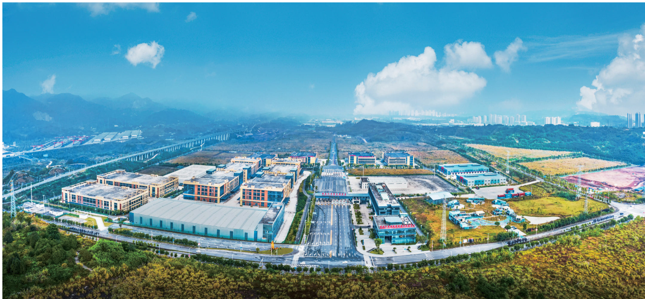
江津正在以“串珠成链、聚链成群”的方式,加快打造成渝地区重要的先进制造业基地。图为江津综保区
