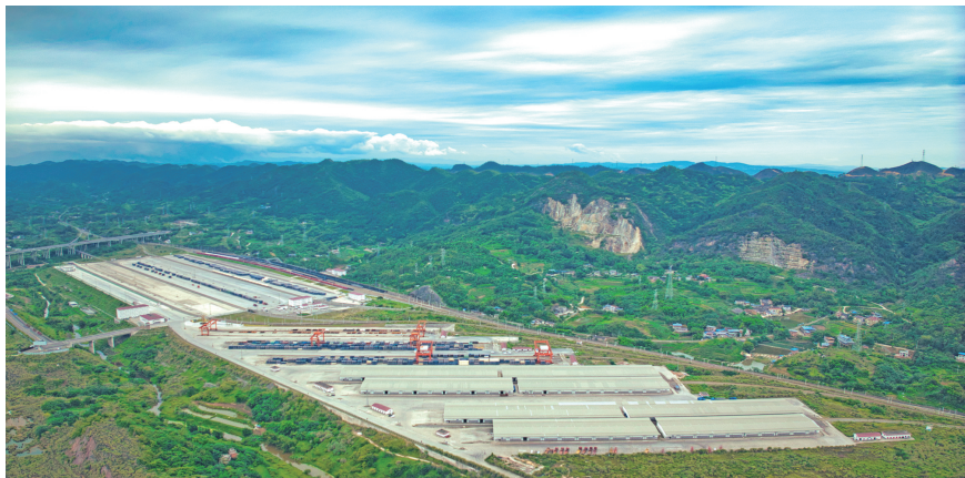
江津加快建设内陆开放前沿和陆港型综合物流基地,初步形成连接西北、畅联西南、面向东盟、通达全球的通道网络,图为小南垭铁路物流物流中心
