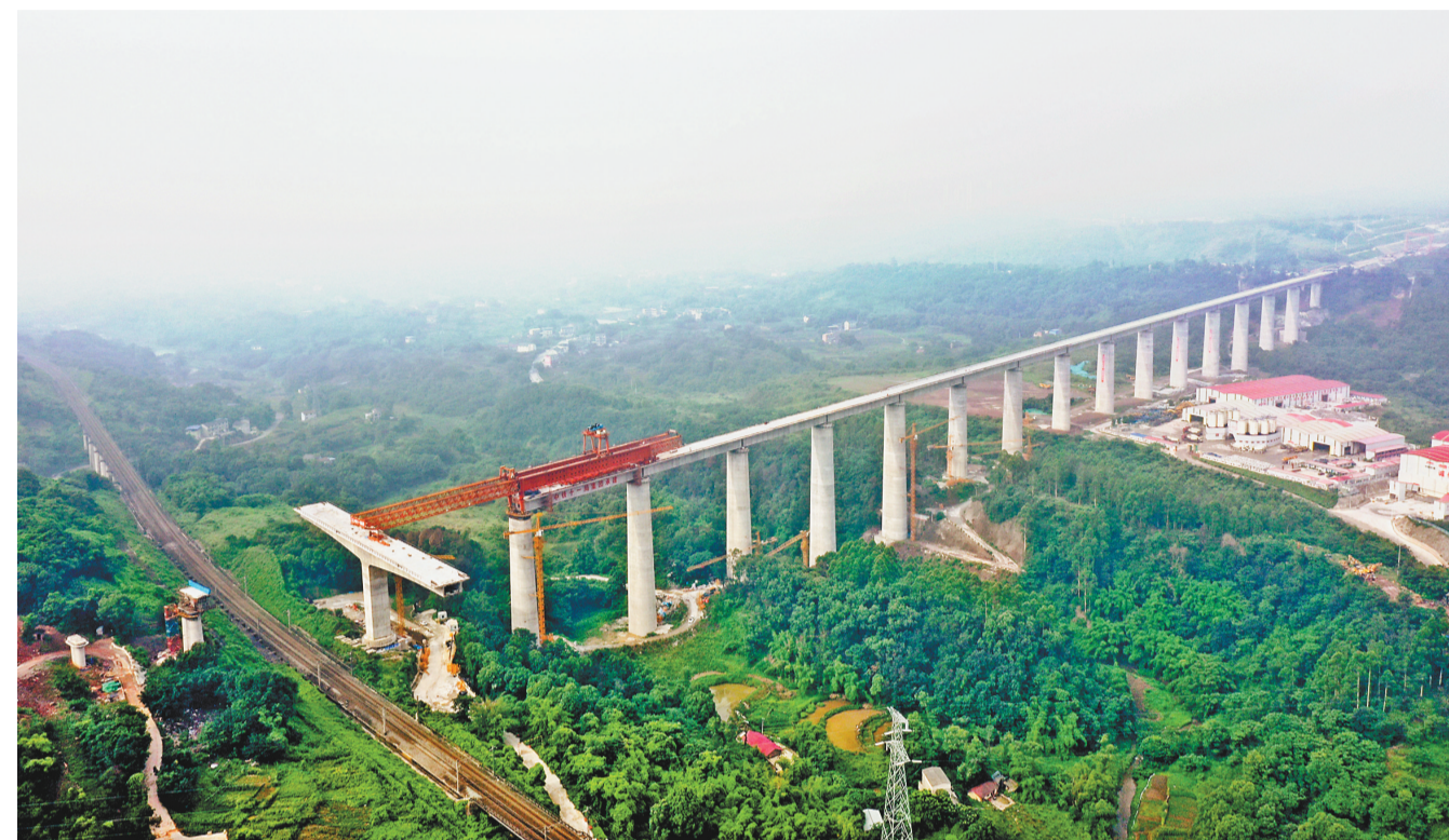
六月二十日，施工人员在渝昆高铁华福特大桥进行拼装梁架。华福特大桥位于高新区境内，全长约一点二公里，为双线特大桥。通讯员 胡志强 摄(视觉重庆)
