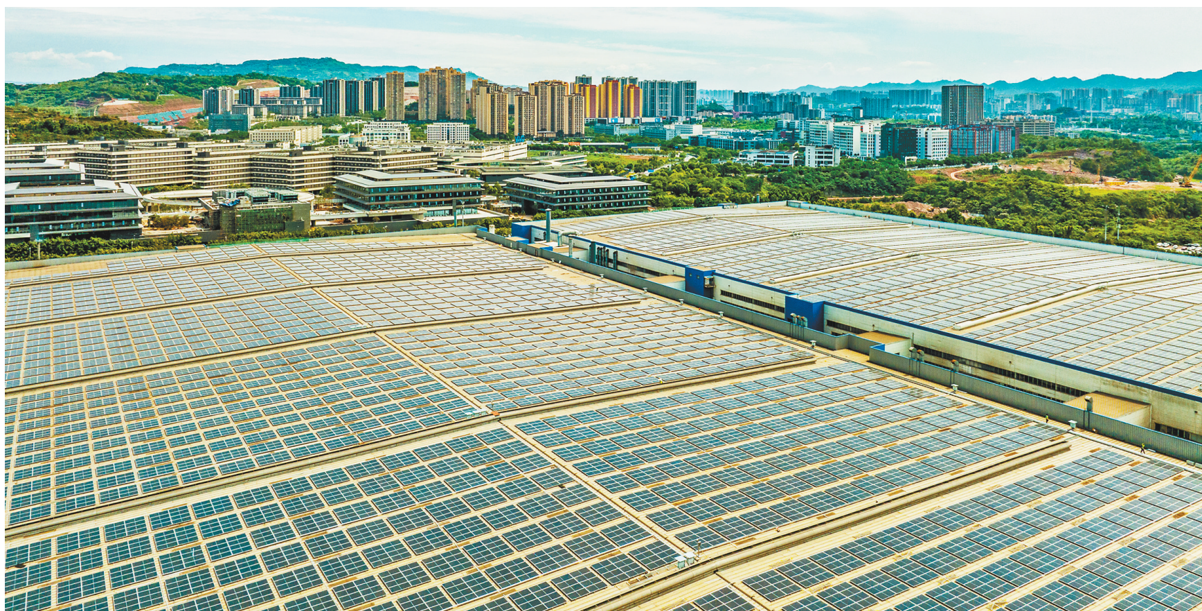
南岸区 屋顶光伏项目并网投运
