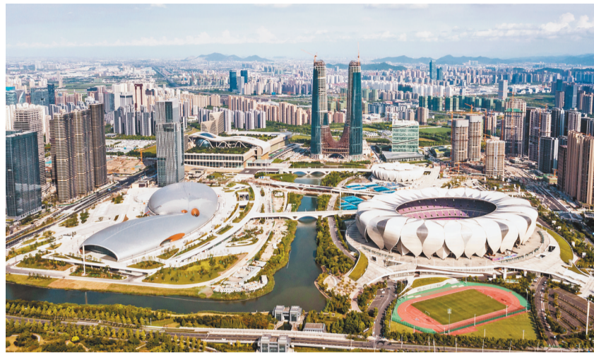
杭州奥体中心场馆群。(摄于2021年8月2日)
