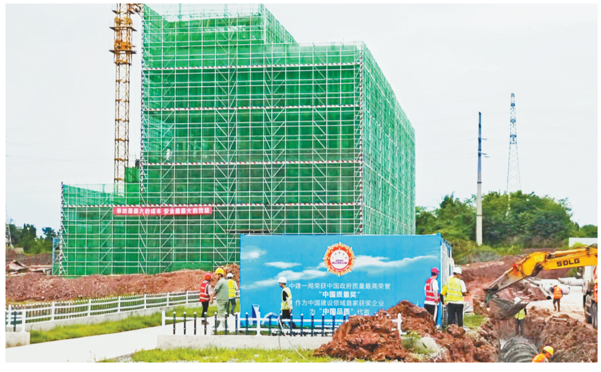
五月三十一日，广安利尔化学股份有限公司二期项目建设现场。记者 崔力 摄/视觉重庆
