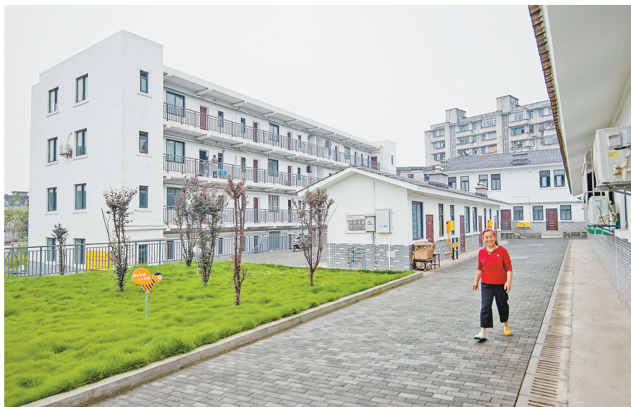
5月19日，九龙坡区铜罐驿镇冬笋街89号，如今的居住环境干净整洁，生活质量大提升。
