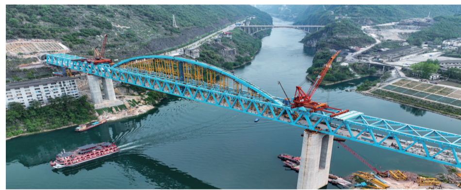
渝湘高铁建设中
