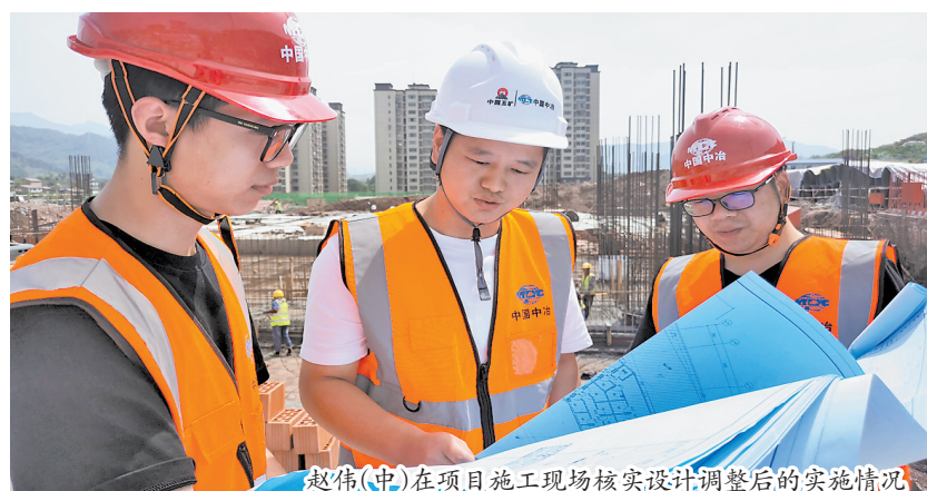
赵伟(中)在项目施工现场核实设计调整后的实施情况
