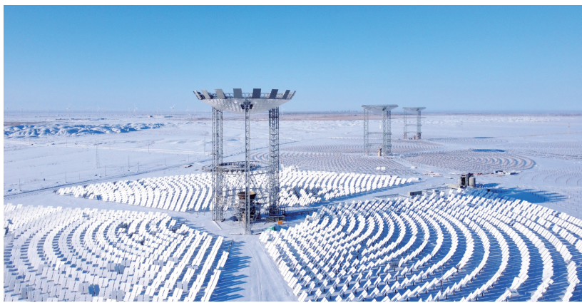
酒泉五门鑫能光热第一电力有限公司5万千瓦熔盐塔式二次反射光热发电项目
