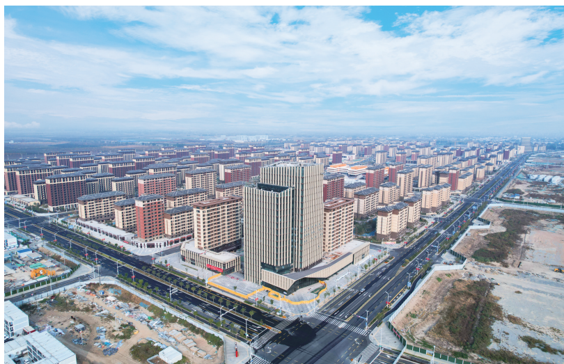
中冶建工承建的雄安新区容西片区安置房项目施工总承包B2标段
