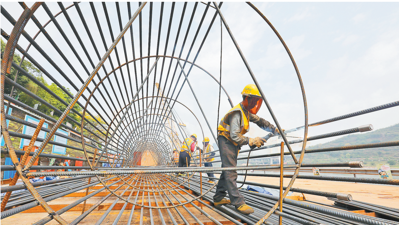
四月三十日,市域铁路跳磴至江津线过江段,中建六局建设工人正在进行大桥主塔钢筋笼焊接。
