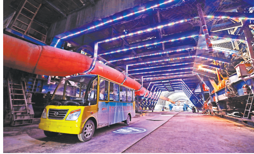
四月二十日,在建的渝遂高速复线绕道云山洞道正加快施工。 记者 罗斌 摄/视觉重庆
