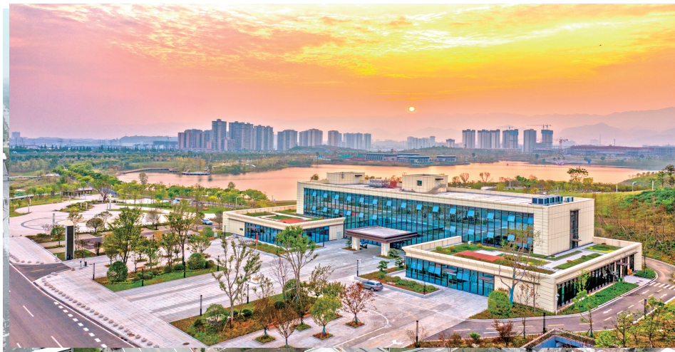
垫江县第一个EPC模式装配式建筑——垫江县管廊监控中心
