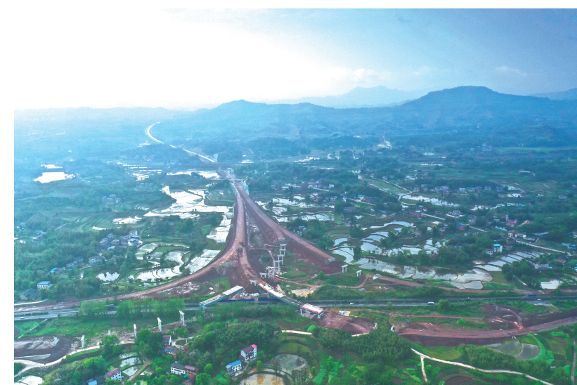
梁开高速公路石莲枢纽互通在建现场
