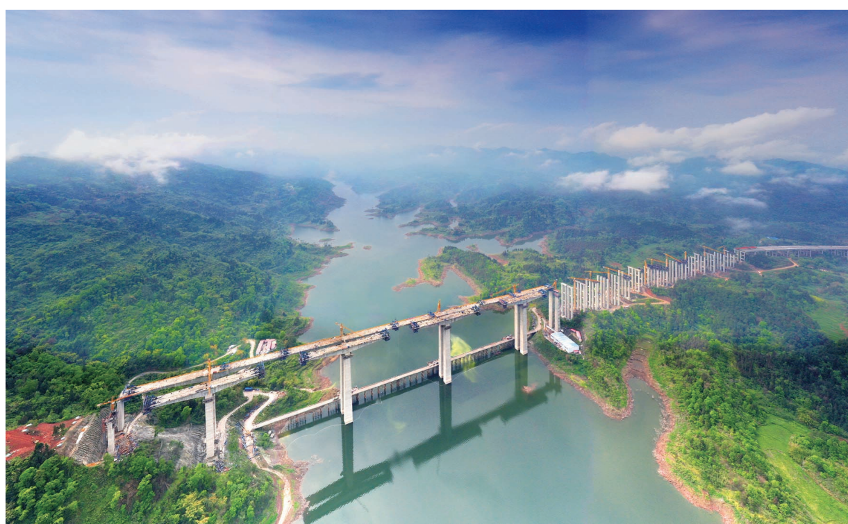
渝湘复线高速五布河特大桥梁建设现场
